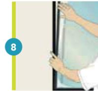
8 Coloque a bagueete de vidro de perfil maior (leito) dentro da travessa e do montante, formando a moldura do vidro.
