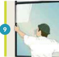
9 Encaixe o vidro dentro da moldura da janela e, ao final, acrescente a bagueete de vidro (4 mm).
