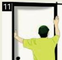
A colocação da porta deve ser feita após a instalação da fechadura e das dobradiças. Não esquecer de requare a porta com os testeiros.
