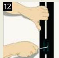
Furar os perfis (batentes) instalados nas divisórias e fixar com parafusos.
