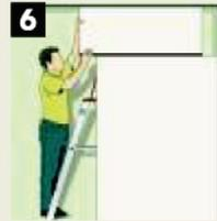
Colocar a bandeira juntamente com a travessa, fechando o módulo de painel cego.
